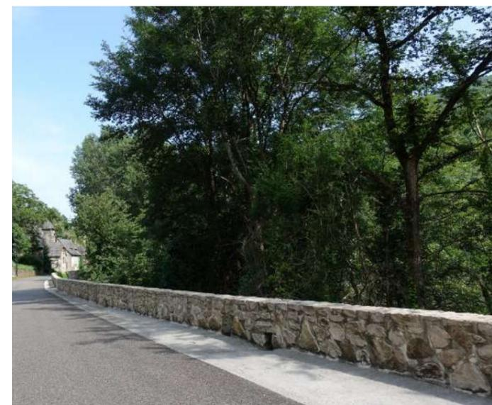
Bande béton en entrée de village au pied du muret de pierres : une façon simple de délimiter un espace piéton et ralentir les voitures. Il faut travailler les formules de béton pour qu'elles soient adaptées au lieu
