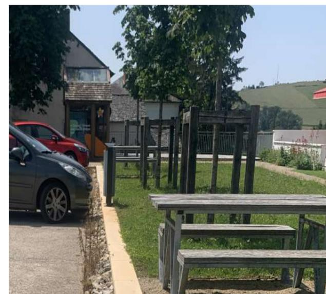
Fond de stationnement avec drain en concassé et sol en béton pour parking
