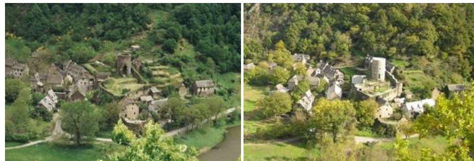
Montarnal avant et après sa réhabilitation
