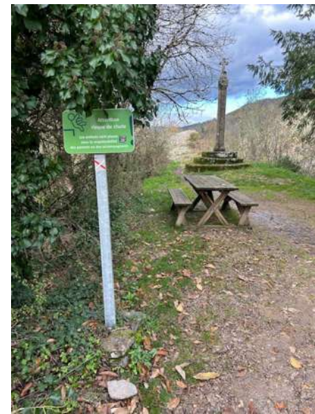
3. Un cheminement vers la croix et l'éperon en belvédère. Signalétique concernant les risques de chute et table de pique-nique, non fixée.
