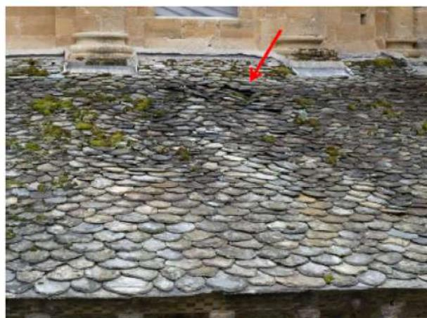
*Détail de la couverture du déambulatoire : couverture en lauzes présentant de fortes ondulations et points directs d'entrée d'eau ; charpente probablement dégradée au niveau des entrées d'eau ; présence de mousses ; décollement des solins.*
