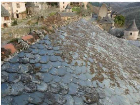
*Détail de la couverture du chœur : couverture en ardoise recouverte de mousses et lichens ; faitage à crêtes et embarrures scellé au ciment présentant des casses et décollements.*
