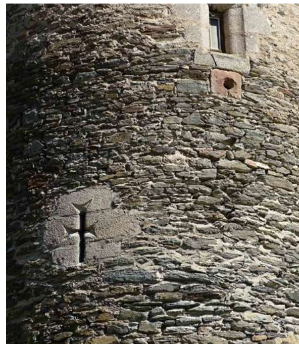
Mur en schiste, archères en granite, bouche à feu en grès
