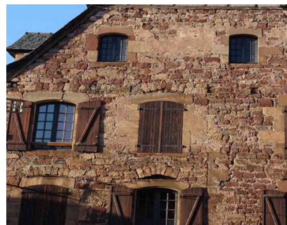
Saint-Cyprien, grès rouge maçonneries et encadrement
