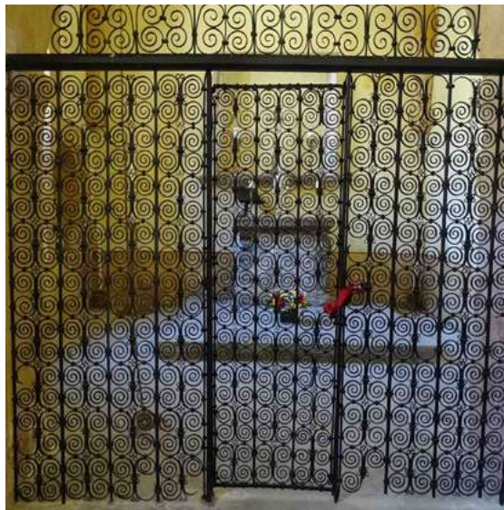
Grille de la chapelle de Montarnal identique à la grille de l'abbatiale ; hypothèse d'ouvrage contemporain ou de réemploi de la grille de l'abbaye
