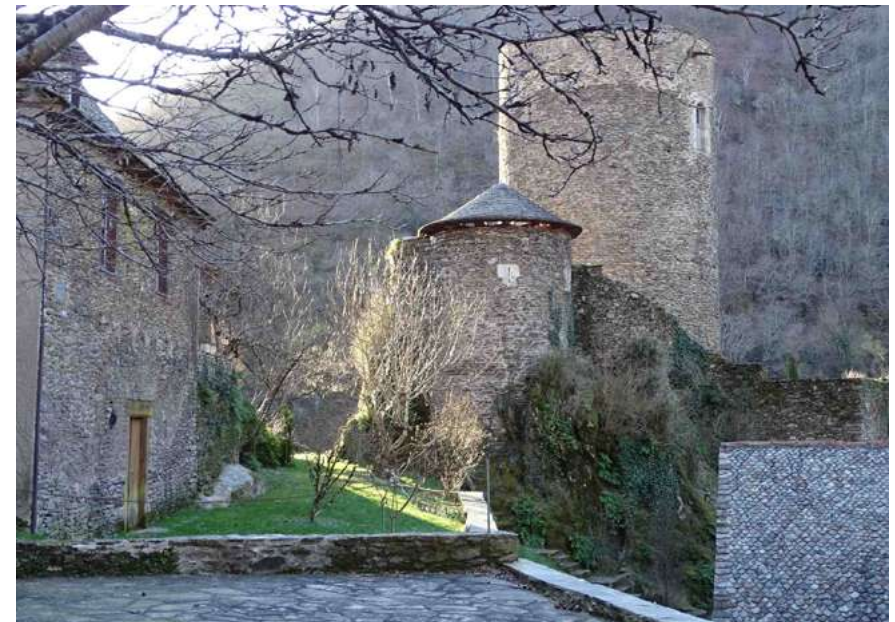
Perception de l'ancien fossé dans le prolongement de la terrasse
