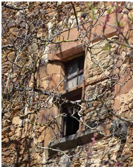
Mur en schiste, encadrement en grès rouge
