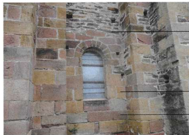
Figure 15 : Diversité des pierres employées dans la construction de l'abbatiale Conques III (Septembre 2014)
